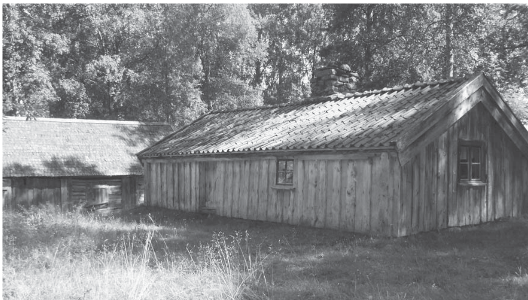
Hus med historia som nu skall rustas upp på Hembygdsgården i Ornunga.
