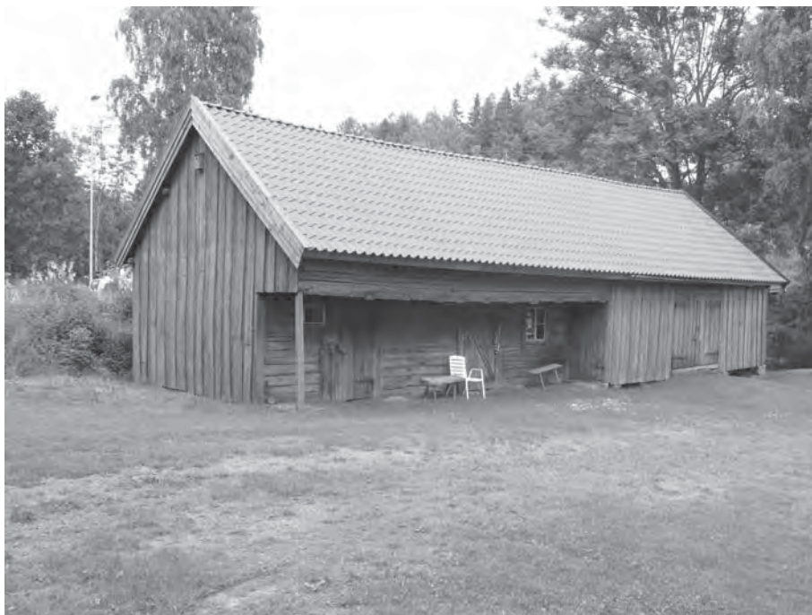
Ladugård med skonke. Skonken var en gång mellan fähuset och ladan så man kunde gå under tak när man bar in fodret till djuren.
