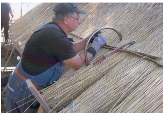
Med en nål , formad som en båge trär Bengt-Rune en tråd runt hasselkäpp och bärlina.
