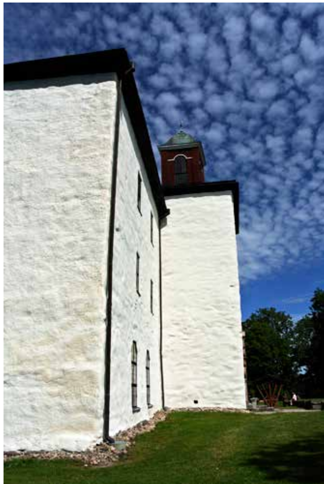
Torpa stenhus Uppskattat besöksmål under sommaren.
