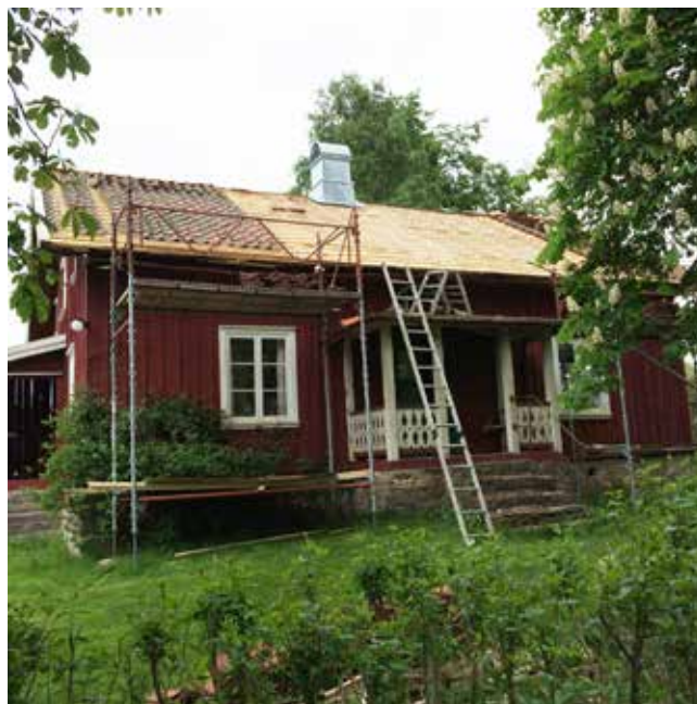
Taket på boningshuset på Askerödsgården renoveras. Foto: Anna Lärk Ståhlberg
