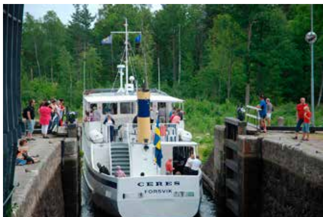
Forsviks sluss, eller Karl XIII:s sluss, är den först byggda slussen i Göta kanal. Den byggdes 1811–13 under ledning av Baltzar von Platen och invigdes i oktober 1813. Bilden är från 2000-talet. Under våren 2020 har nya slussportar monterats och en upprustning av området har skett.
