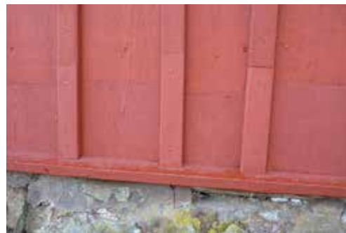
Lagning av brädfodring på huvudbyggnaden.
