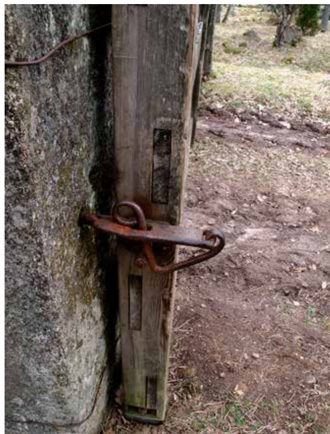
Hemmagjort lås. Det här låset sitter på en av grindstolparna som går ner till maderna vid Sällershögsvägen. Portstolparna har tidigare funnits vid uppfarten till Sällershög och troligen är det Adolf Johansson på Sällershög som smitt låset i gårds-smedjan.
