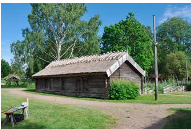
Rackeby. Den stora knuttimrade hushållsboden kommer liksom stugan från Storegårdens by i Rackeby socken. Till Fornbyn kom den 1923. Den härstammar från 1700-talet och består av fyra bodar med separata ingångar och har använts till förvaring av gårdens matförråd.
