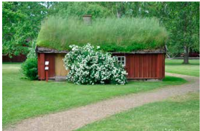
Kungslénastugan. Det finns ett 30-tal byggnader samlade i friluftsparken Fornbyn i Skara. Ryggåsstugan ovan är från 1700-talet och kommer från Kungslena kyrkby utanför Tidaholm. Huset flyttades redan 1914 till Stadsträdgården i Skara, och 1951 till sin nuvarande plats. Stugan är knuttimrad med tak av torv och vass. Planen är en enkelstuga med en storstuga och en förstuga. Till eldstaden i bostadsrummet hör en bakugn.
