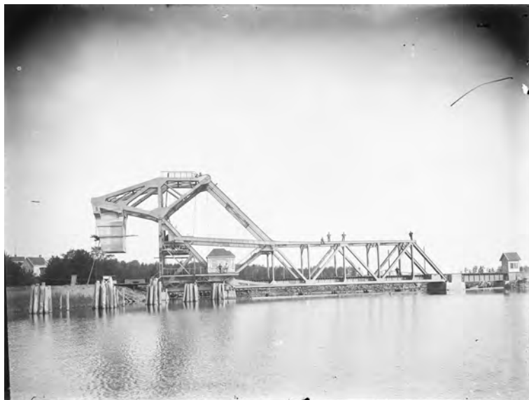
Klaffbron för järnvägen över Trafikkanalen, här under byggnad. Bild från Kulturlagret, Vänersborgs museum.
