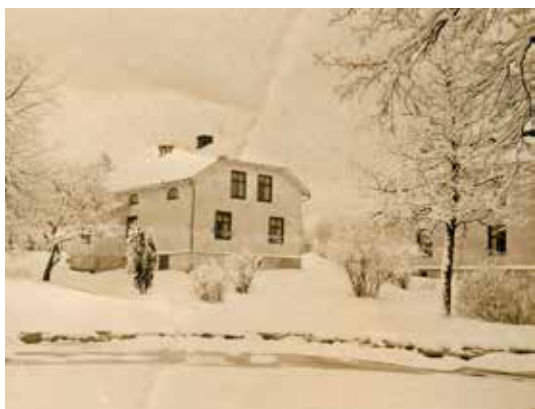
Strömma, Sätila, i början av 1920-talet. Man-gårdsbyggnaden från slutet av 1700-talet. Från familjealbum.
