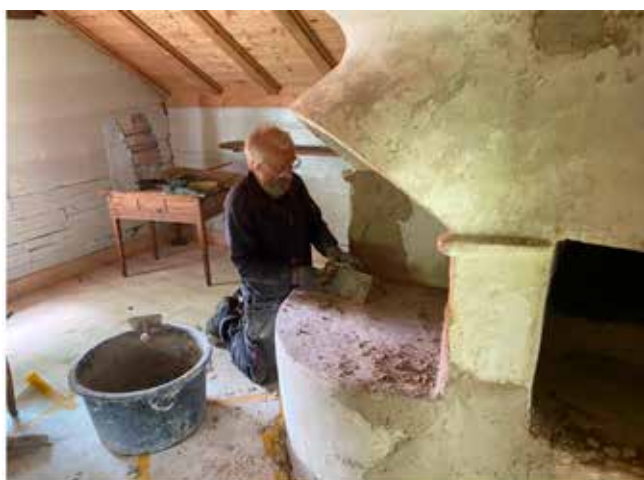
Spisen var i dåligt skick, så det fick till en grundlig renovering och puts med kalkbruk
