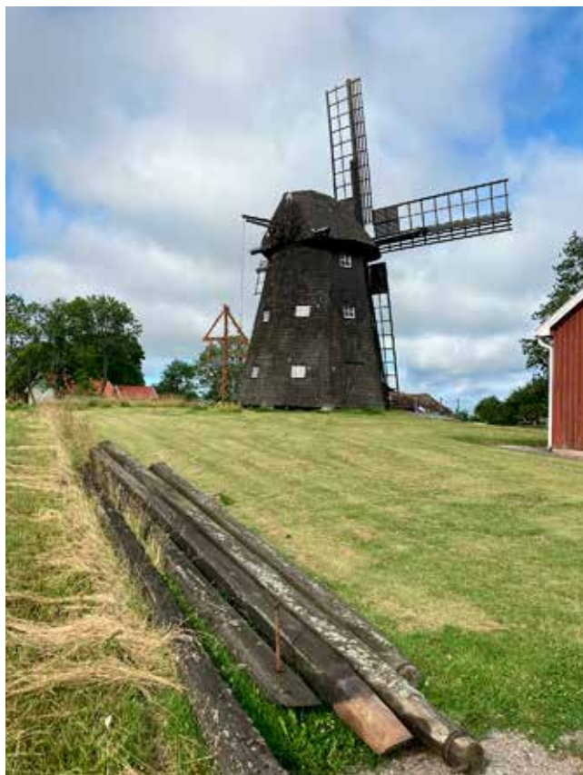
Kvarnen i Söne. Renovering påbörjad. Foto: Privat.
